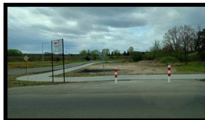
Ścieżka rowerowa ul. Międzyrzecka
