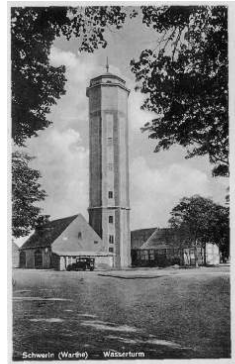
15. Wieża - Wasserturm - The water tower Wydawca - Verlag - Publisher: Julius Rauh (ob./um./ca. 1934 r.)
